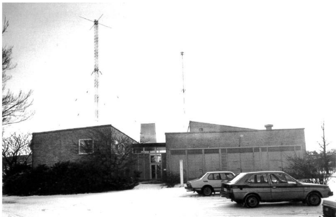
Figur 19. Foto från 1980-talet. Rundradiostationen med dess två master. Huset ritades av arkitekten Sven Brolid. Källa. Byggnadshistorisk utredning (Tyréns, 2019-10-08).
