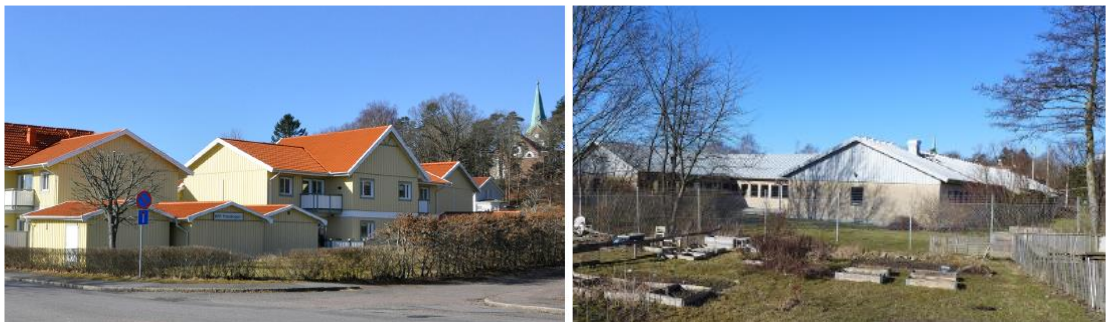
Figur 18. Till vänster: Flerbostadshus uppförda i en kvartersstruktur vid Järnbrotts Prästväg, väster om planområdet. Till höger: kontorslängor för telegrafverket byggda på 1970–80-talet med prefabricerade fasadelement inom planområdet. Källa: kulturmiljöutredningen (Antiquum, 2018-08-29).
